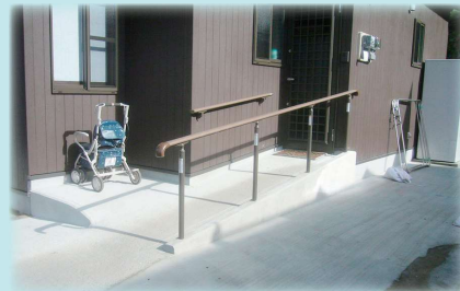
勝手口スロープ取付
